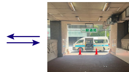
【ATAMIX 熱海第一ビル】 (南側 地下1階入口付近)
